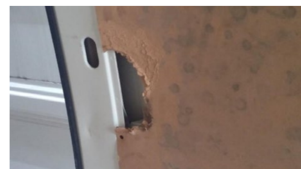
Вътрешни дървени предпазни елементи: Следи от удари, скъсани панели, липсващи панели (с изключение на горните панели на вратите)
