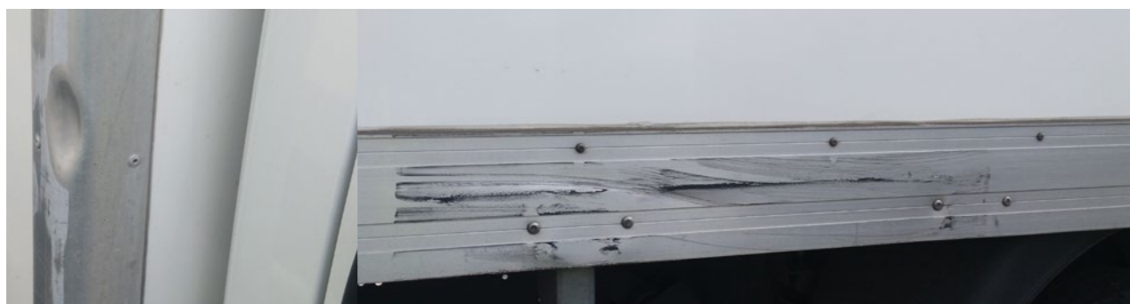
Странични профили на долната част на каросерията: Деформации, чийто ремонт е икономически изгоден
